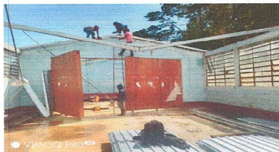
Foto 2: COLACACION DE ESTRUTURAS METALICAS DEL MODULO No. 1
