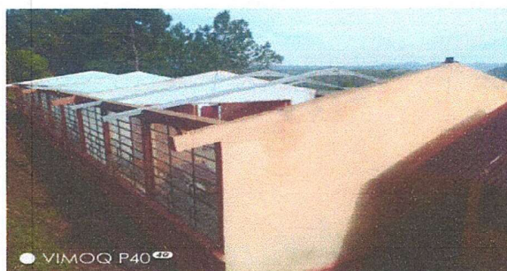
Foto 4: SUSTITUCION DE ESTRUTURAS METALICAS DEL MODULO No.1
