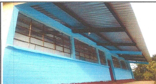
Foto 6: PINTURA EXTERIOR MODULO No. 2
