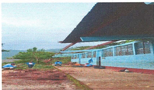
Foto 1: DESMANTELACION DE LA CUBIERTA DE LAMINA
