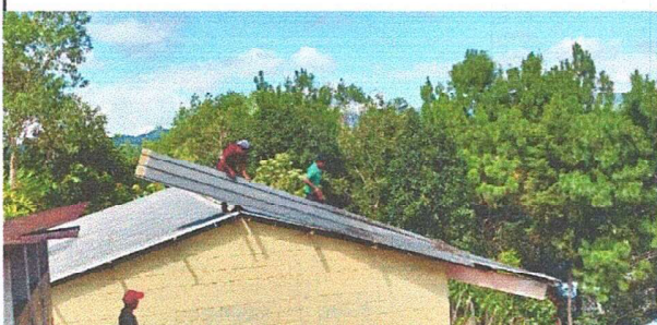
Foto 5: DESMANTELACION DE LA CUBIERTA DE LAMINA DEL LADO DERECHO DEL MODULO.
